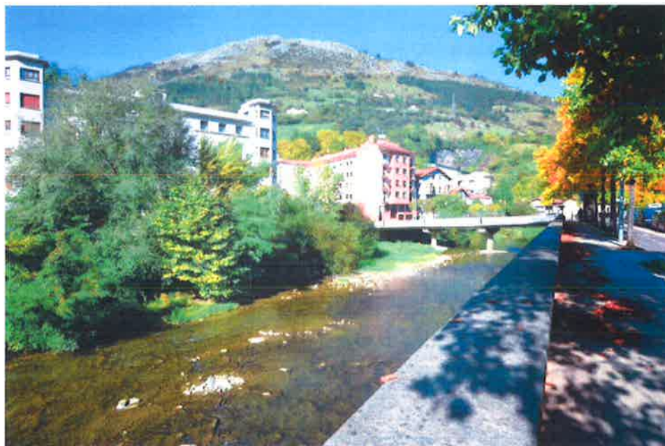
1.- PUENTE EN EL PERFIL 1660.894
