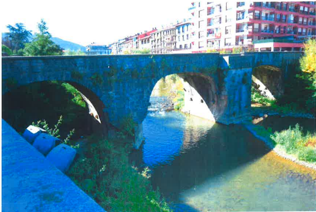
3.- PUENTE EN EL PERFIL 1891.387
