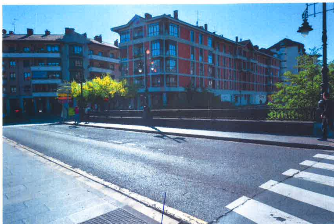
12.- PUENTE SITUADO EN EL PERFIL 2228.458
