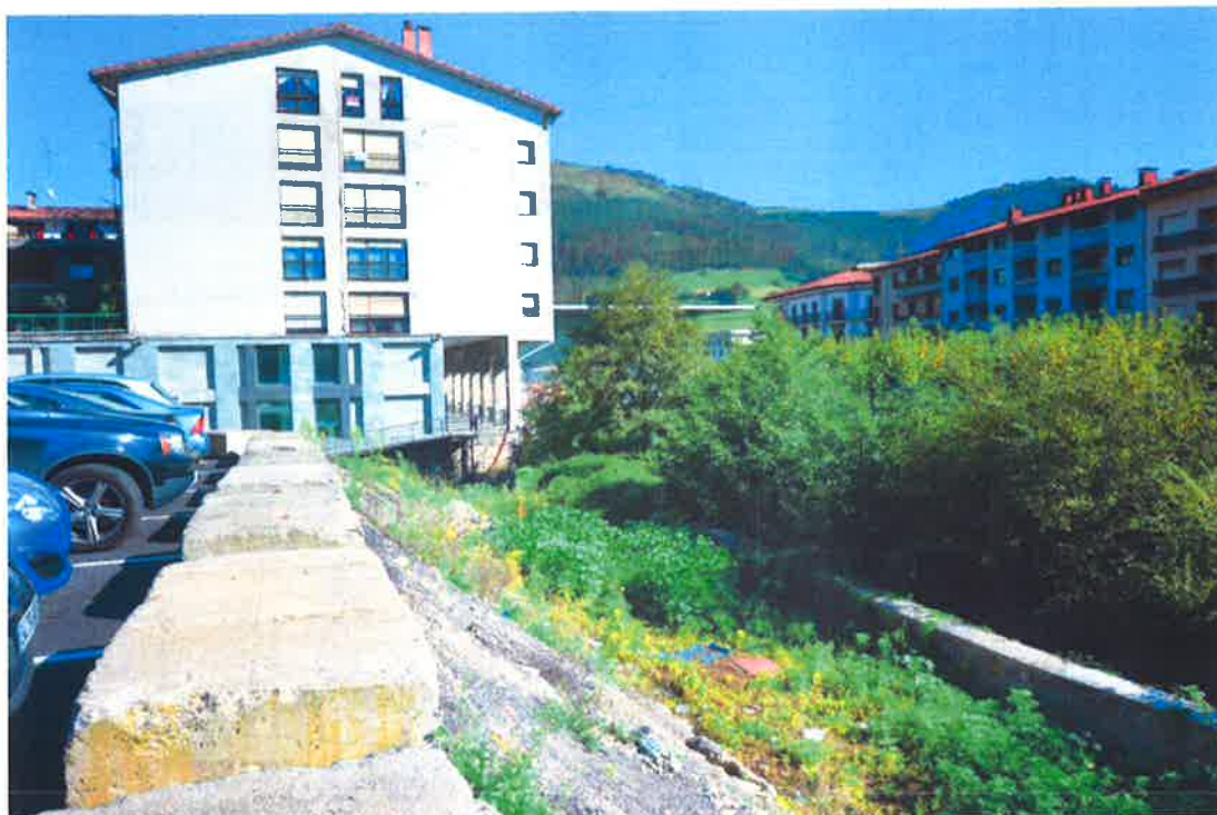
11.- SITUACIÓN ACTUAL DEL ÁMBITO ALDE ZAHARRA
