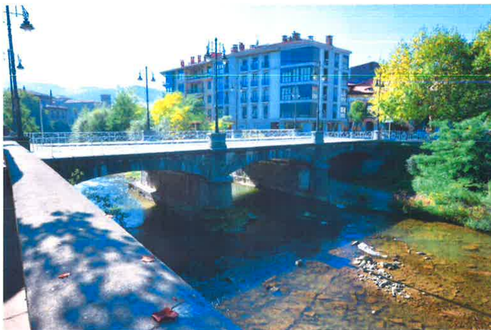
2.- PUENTE EN EL PERFIL 1755.124
