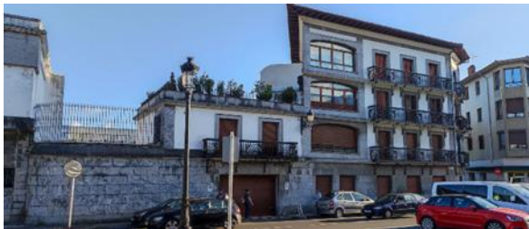
Etxebizitza-eraikina Foru Pasealekuan
