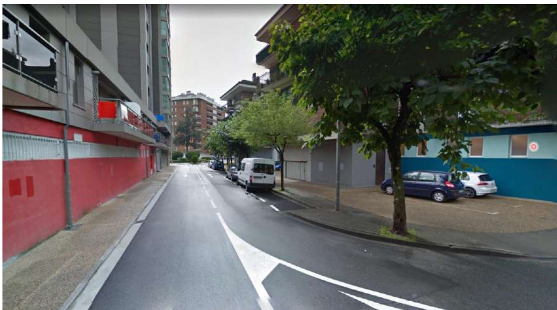
Fotografía. 12. Tramo de calle Urbitarte. Fuente Google maps.
